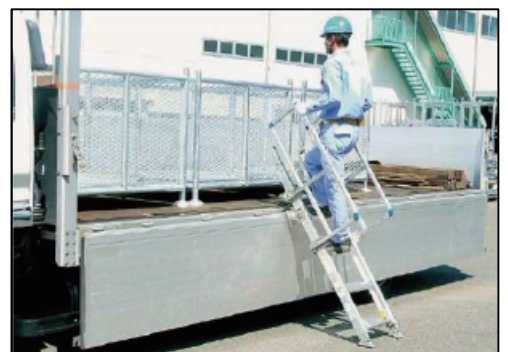
▲側面あおりを倒して設置
